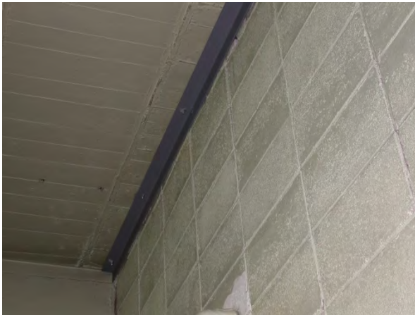
室内間仕切り壁上部(補強後)
