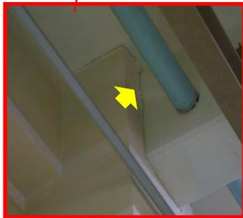
梁と柱の接合部ひび割れ
