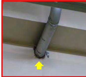
蒸気戻り配管壁貫通部の壁ひび割れ
