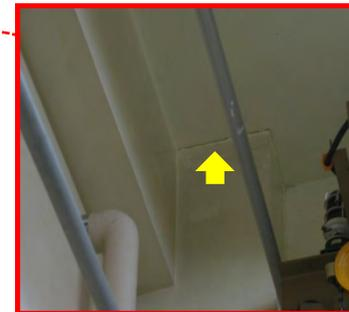
柱の天井接合部ひび割れ
