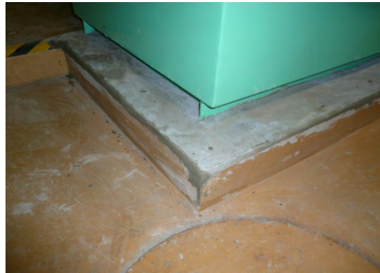
補修後 (平成23年6月6日撮影)
