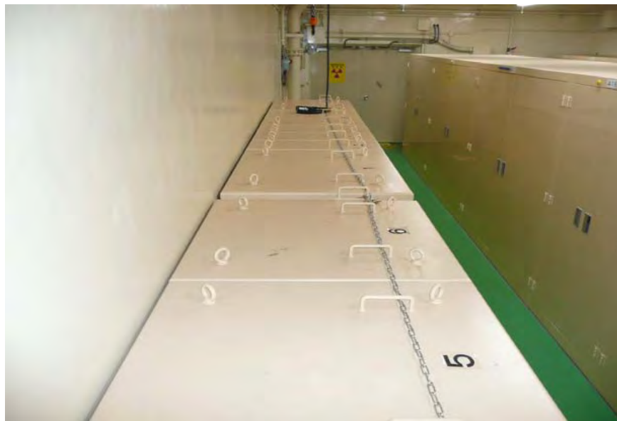
補修後(平成24年3月2日撮影)
