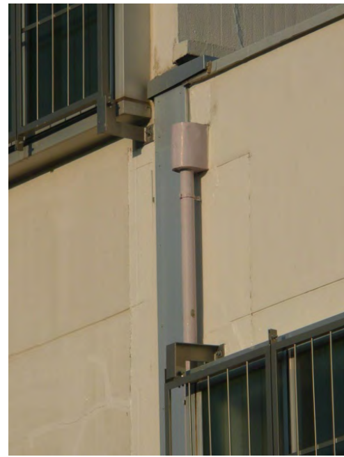
補修後(平成24年9月28日撮影)
