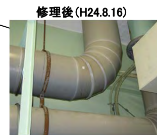
使-01~1 プルトニウム研究1棟108号室排気第8系統、排気第10系統ダクト配管亀裂
