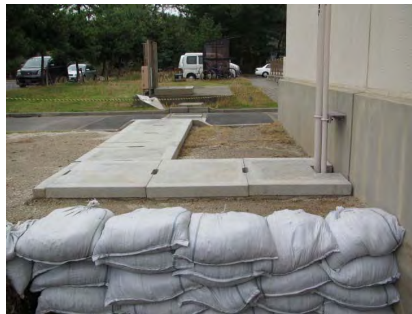
重油配管2本の破断(復旧後) (H23.10.12)
