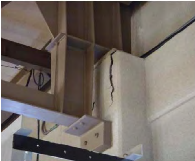
炉-39 第2廃棄物処理棟 屋根支柱上部の損壊
