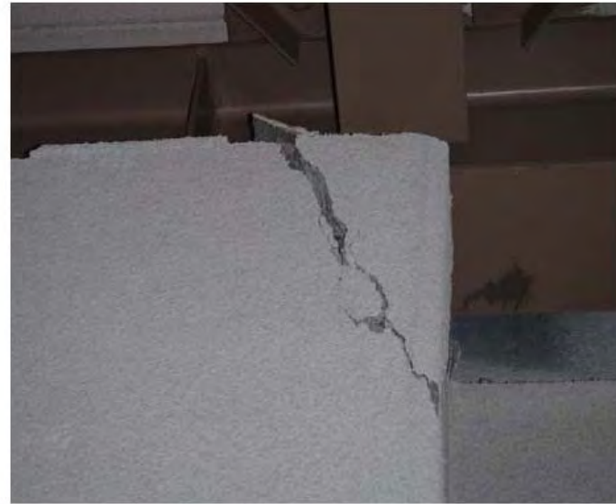
炉-39 第2廃棄物処理棟 屋根支柱上部の損壊
