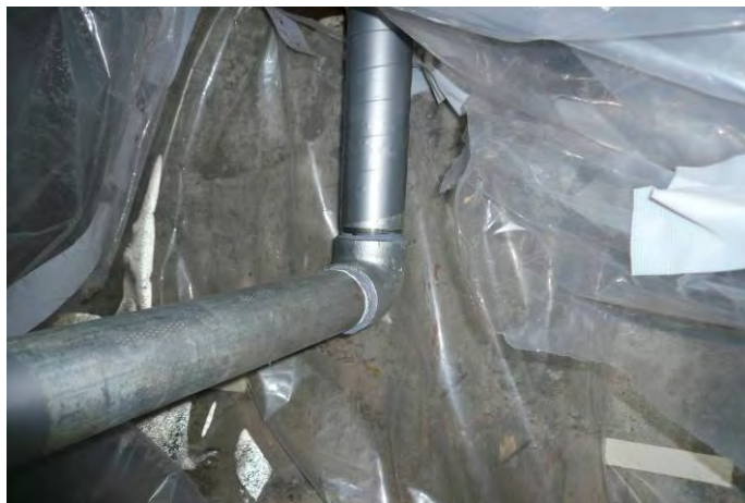
補修後(平成23年11月30日)
