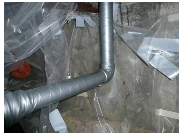
通水試験後防食テープ二重巻き (平成23年11月30日)
