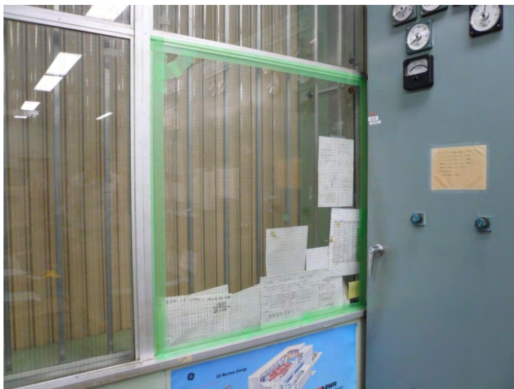
アクリル板による目張り H23.3.28撮影
