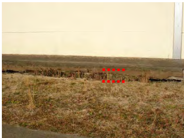
原子炉建家周辺の地盤沈下
