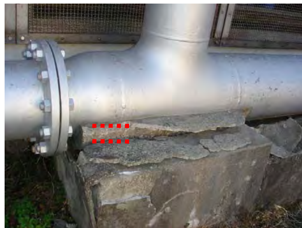
2次冷却塔周辺の地盤沈下
