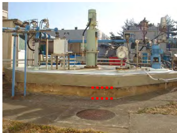
廃液中和槽周辺の地盤沈下
