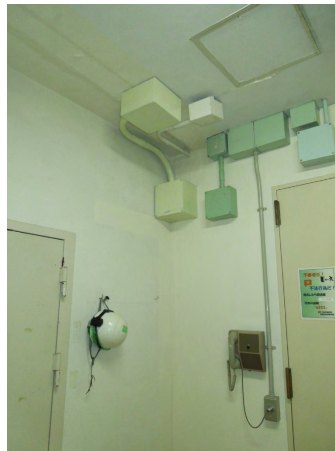
通路の天井と壁面のひび補修後
