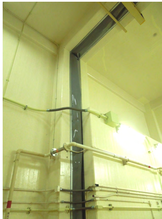
内側からみた亀裂の補修
