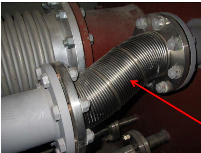
共同溝内の非常用排気設備配管エキスパンション部の芯ずれ
