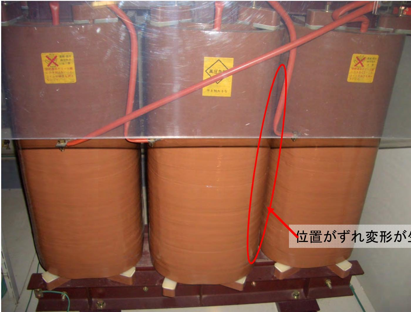
位置がずれ変形が生じている
