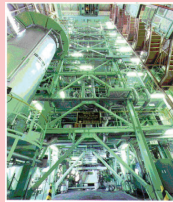
大型非定常 試験装置 (LSTF)
