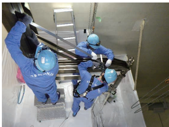
燃料交換装置の点検(写真2)
