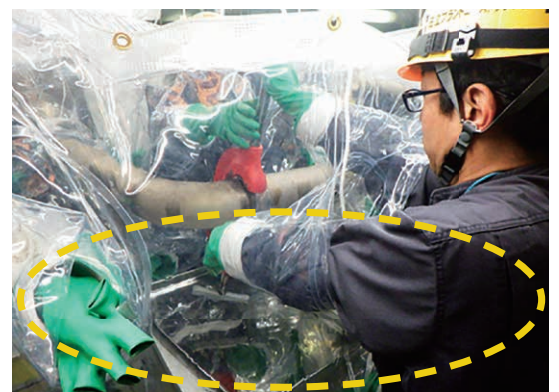
プラバッグを用いた作業の様子(写真4)
