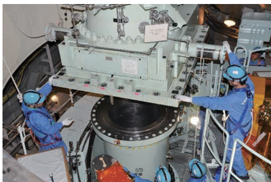
燃料交換装置の復旧(写真1)
