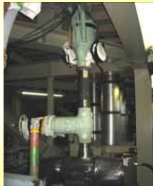
〔蒸気発生器放出弁の追加〕
