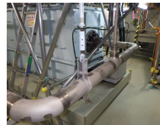
予熱・保温設備（解体後）
