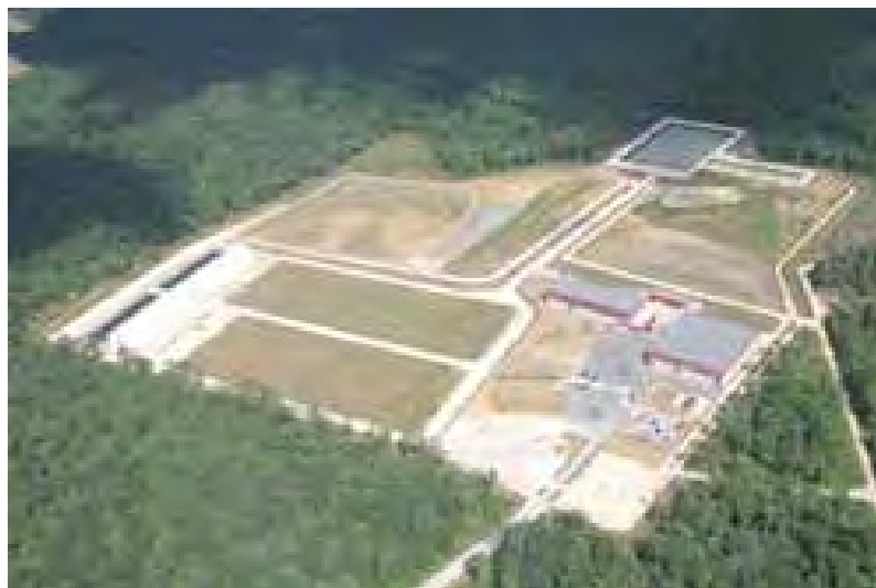
図 8.2.1-4 モルヴィリエ処分場の鳥瞰図--- JAEA ふげんデコニュース [7] より
