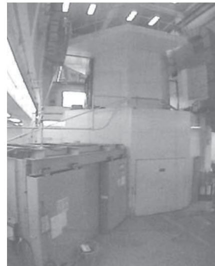
構造物の外観
