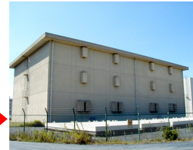
保管廃棄施設
