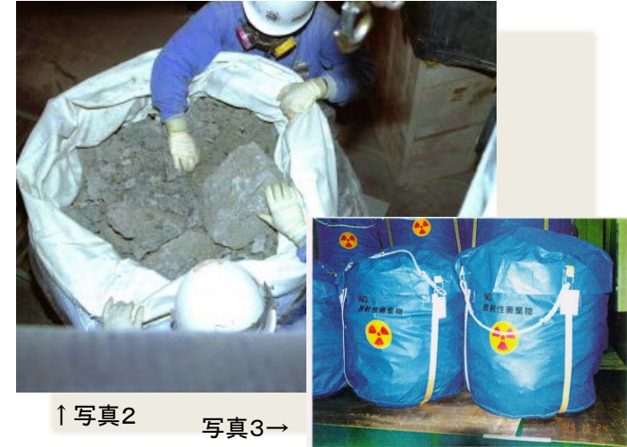
コンクリート等廃棄物のフレキシブルコンテナへの収納
