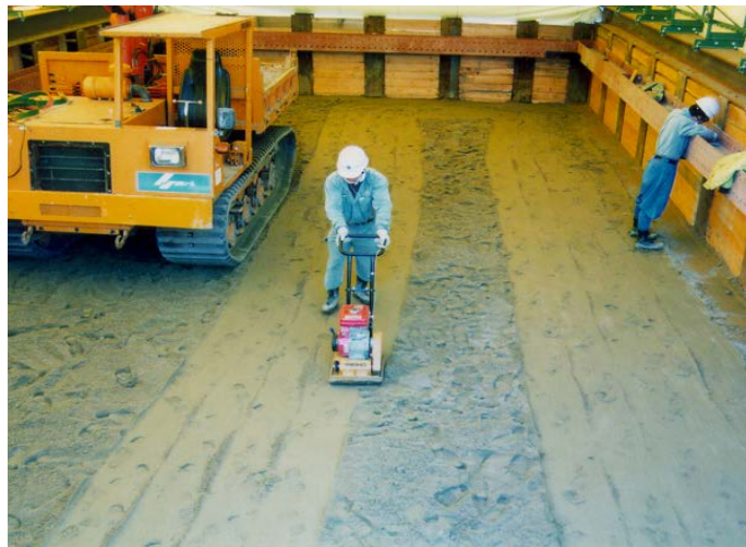
写真5 中間覆土の転圧作業状況(第1区画第2段)
