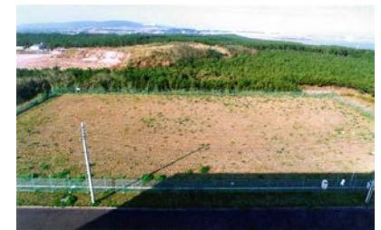
写真6 廃棄物埋設地(覆土終了後)
