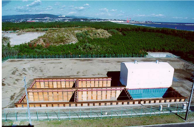
写真1 廃棄物埋設用トレンチ外観及び雨水浸入防止用テント (定置開始前)
