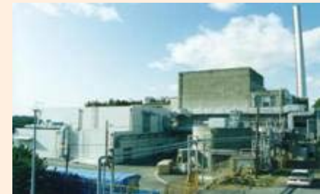
解体中の原子力施設
