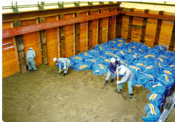
写真4 土砂充填(中間覆土)作業状況
