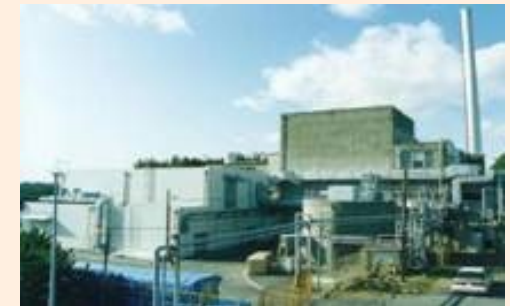
解体中の原子力施設
