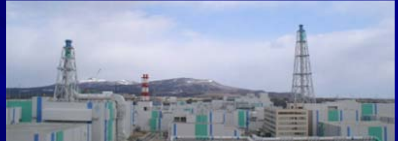
Rokkasho Reprocessing Plant (JNFL)
