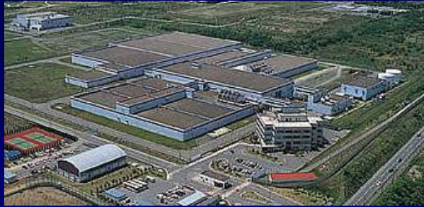
Rokkasho Uranium Enrichment Plant (JNFL)
