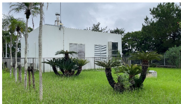
沖縄観測所外観 草刈りなどの手入れが大変
