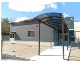
ISCN実習フィールド建屋 (1-1 新ISCN実習フィールドの紹介)
