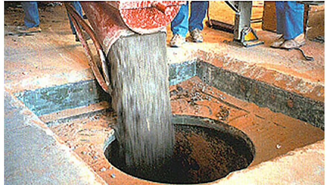
**Kalahari核実験場のシャフトへのコンクリートの流し込み**
