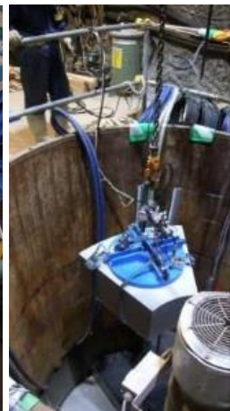
緩衝材ブロックの製作と試験孔への定置
