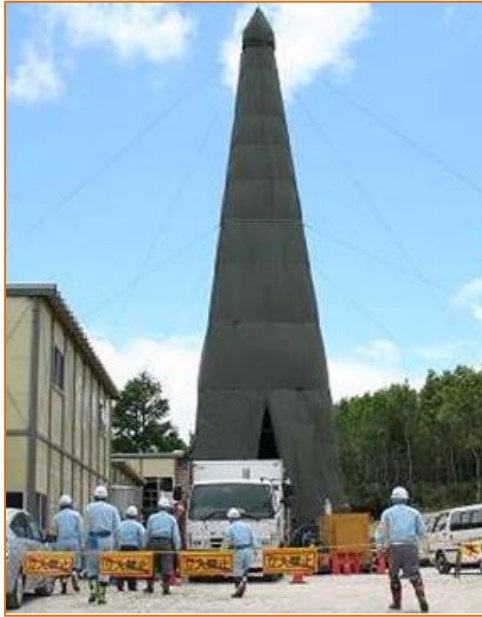
ボーリング調査（HDB-11孔）
