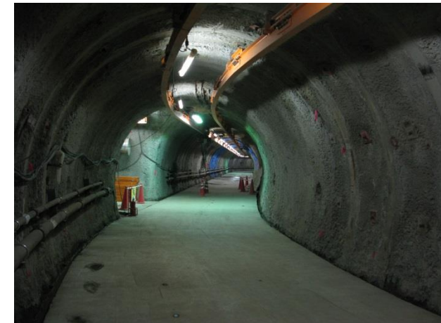
深度350m調査坑道 (平成26年2月25日撮影)
