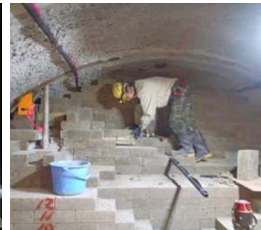
埋め戻し材の施工(左:転圧締固め、右:ブロック積み上げ)
