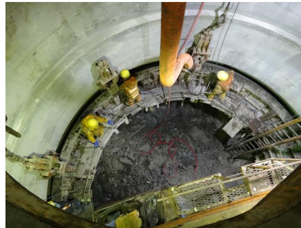
東立坑 (平成26年3月26日撮影)
