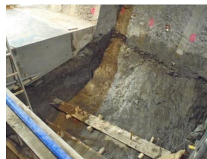
切り欠きの掘削とプラグの施工例
