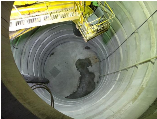
西立坑 (平成26年3月26日撮影)
