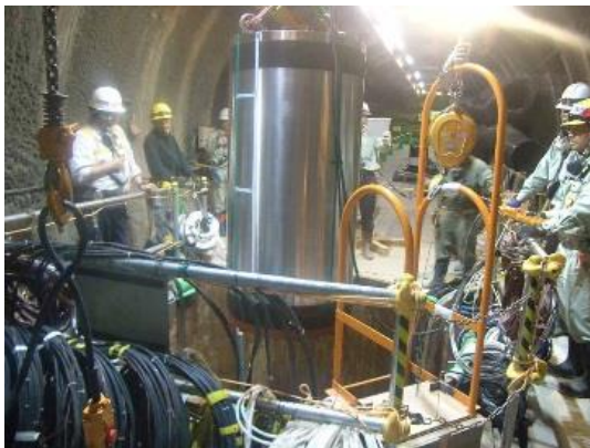
人工バリア性能確認試験（オーバーバックの設置）
