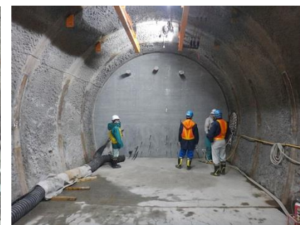
切り欠きの掘削とプラグの施工例
