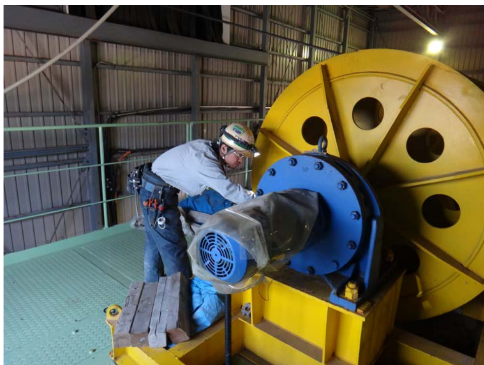
機械設備の維持管理の様子
