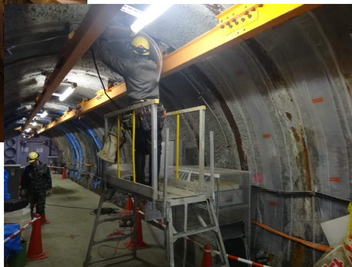
地下水の排水用シートの更新
