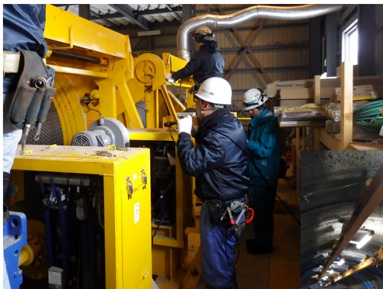
機械設備の点検・整備
