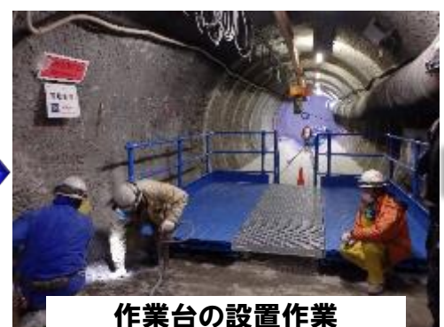
鋼製型枠の設置(組立台)
