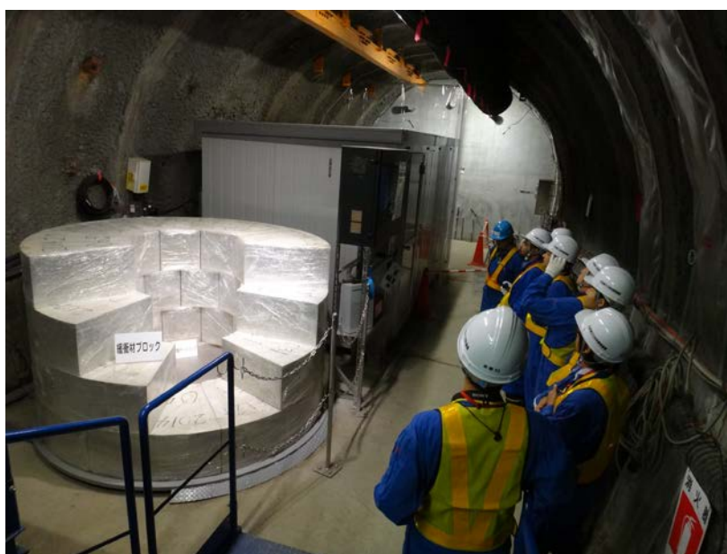
350m調査坑道での見学の様子
