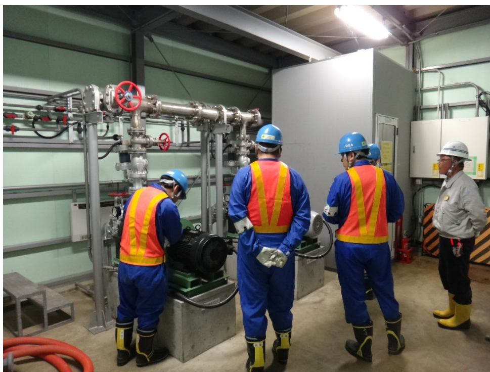
安全パトロールの様子
