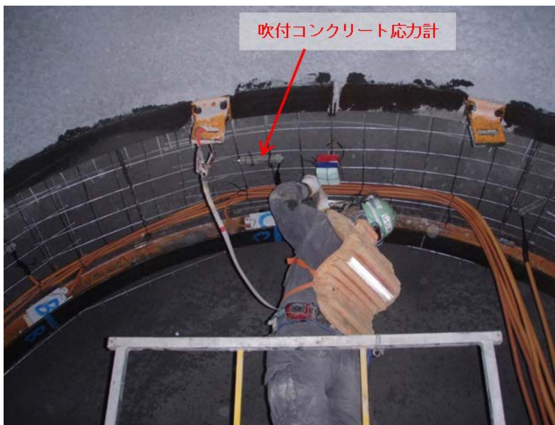
吹付コンクリート応力計の設置の様子
