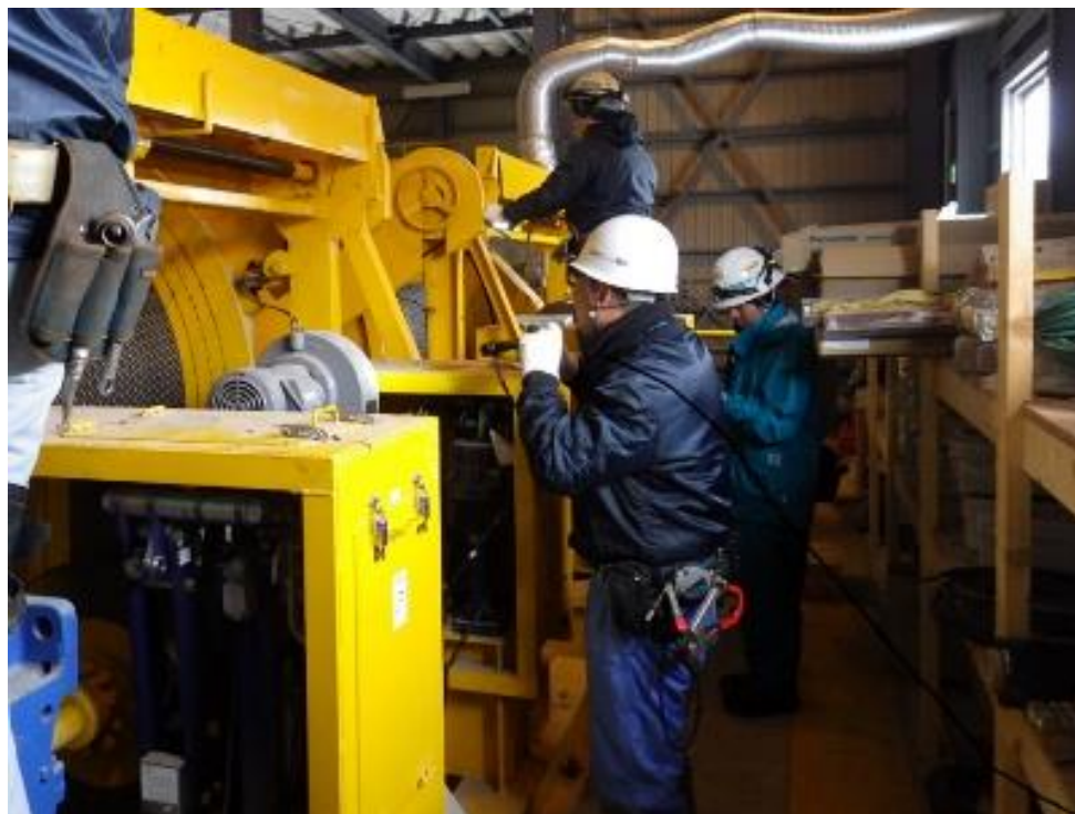
機械設備の維持管理の様子
