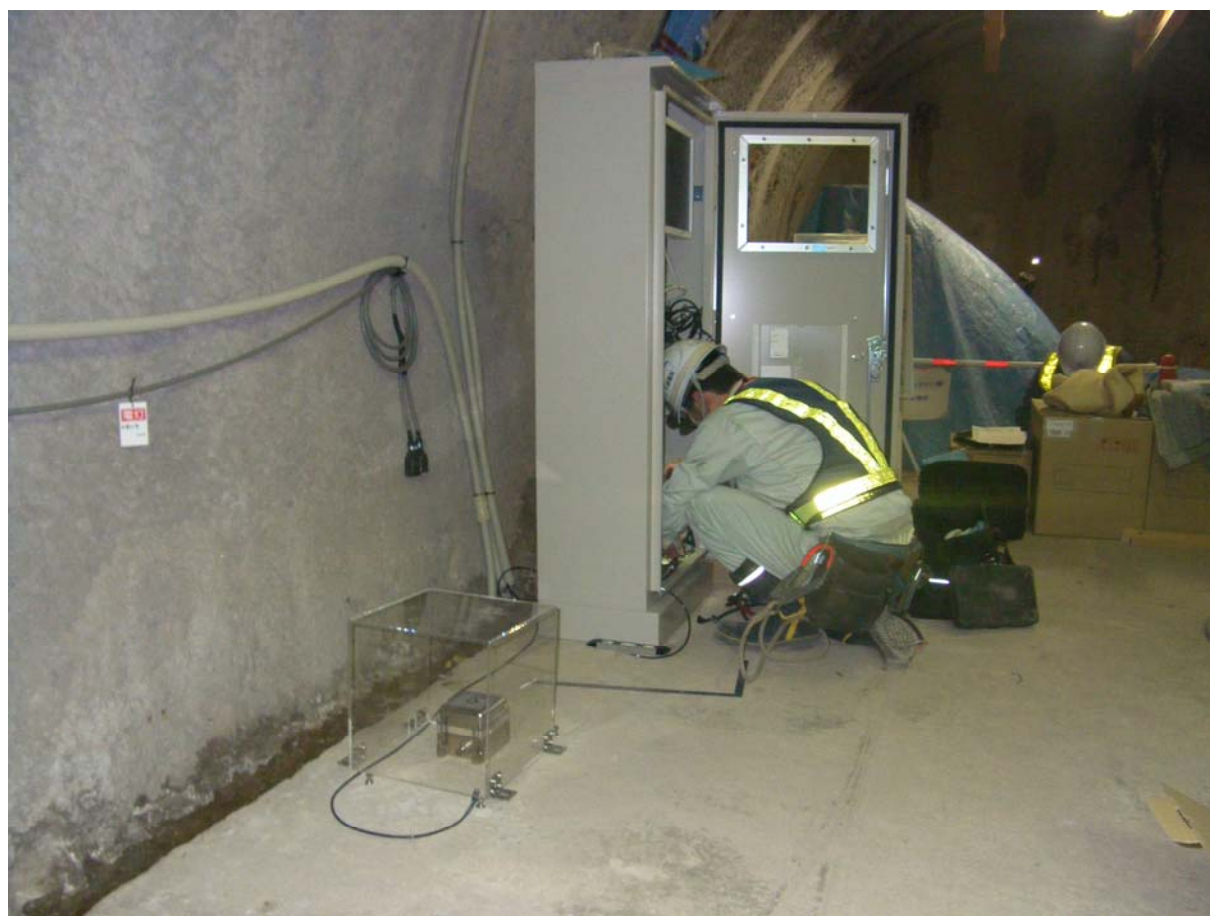
地震観測モニターの設置の様子
