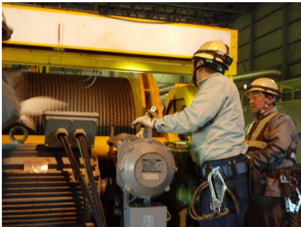
機械設備の維持管理の様子
