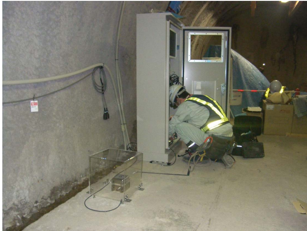
地震観測モニターの設置の様子
