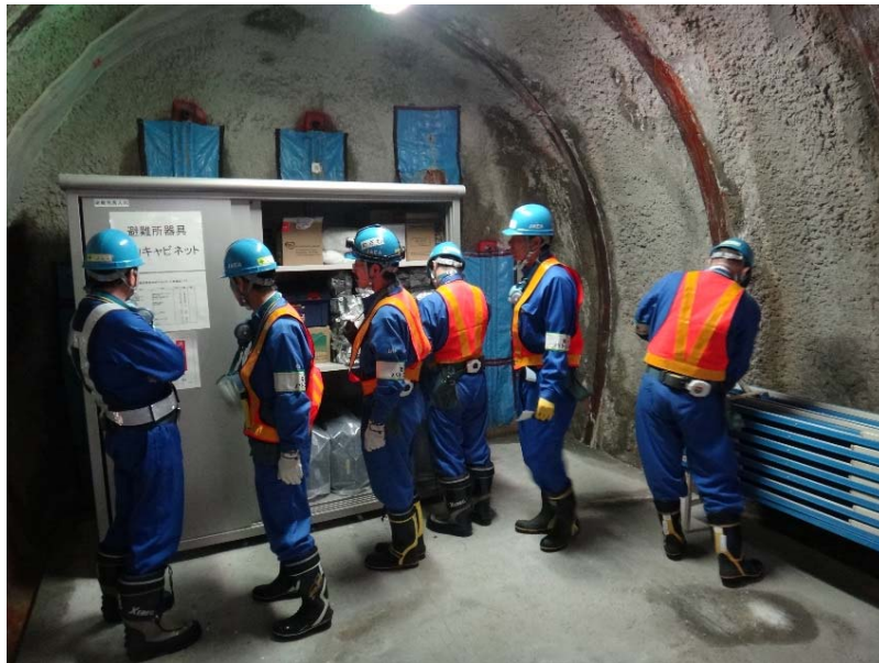
避難所器具の点検作業
