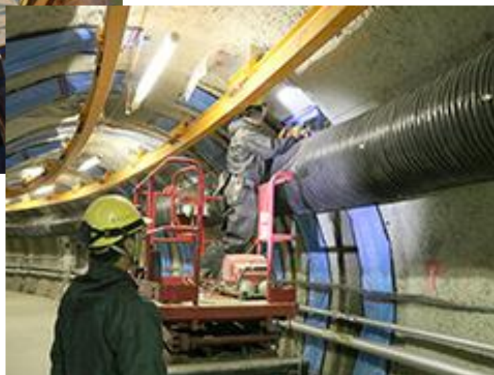
地下水の排水用シートの更新
