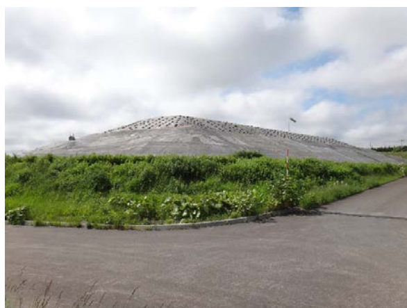
写真7 掘削土(ズリ)の保管状況
