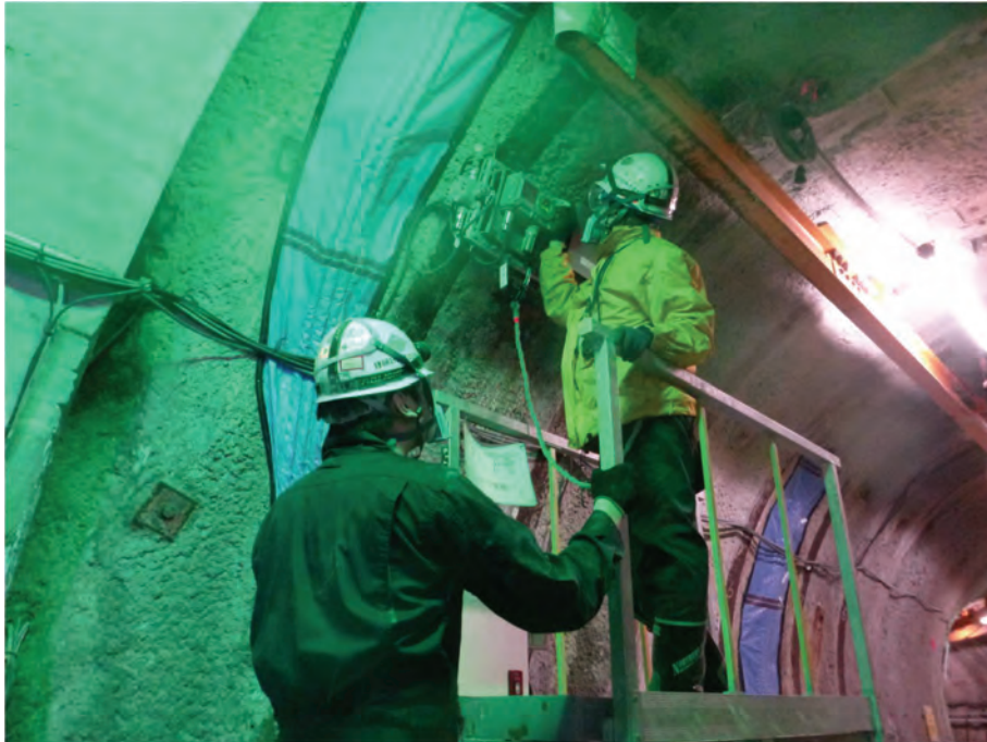
ガスセンサーの点検作業
