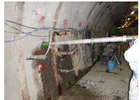
試験装置の設置
