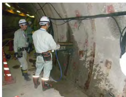
ボーリング孔の掘削
