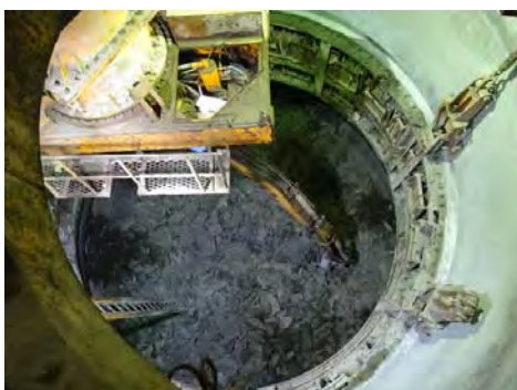
建設状況 : 東立坑の掘削
