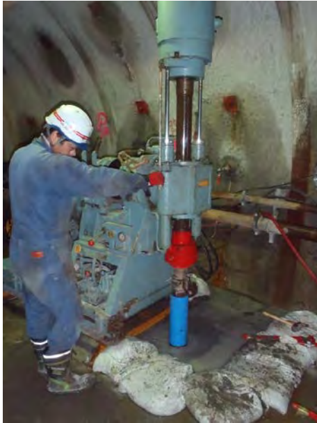
写真 33 健岩部を対象としたボーリング実施状況
