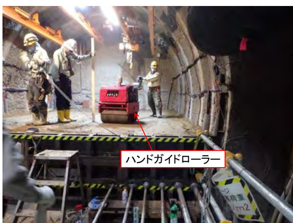
写真 9 埋め戻し材の転圧締め固め状況
