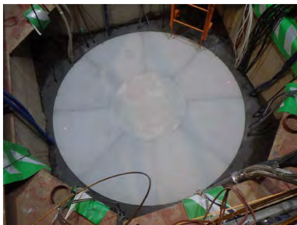
写真 8 緩衝材設置完了（12段）
