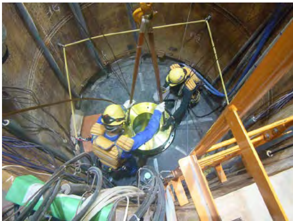
写真 6 おもりの設置 模擬オーバーパック内部におもりを設置します。
