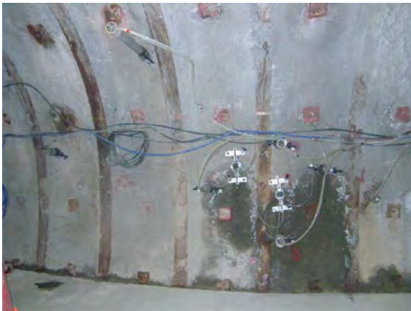
写真 39 単一割れ目を対象と した原位置トレーサー試験 (孔内部装置設置後)
