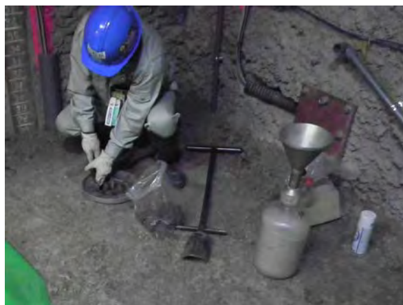
写真 32 坑道下部からのサンプリング状況（27層目）
