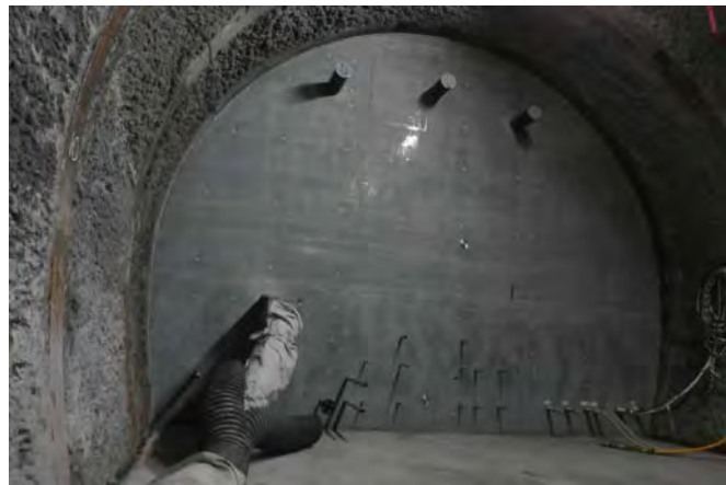
写真 13 コンクリートプラグ施工完了
