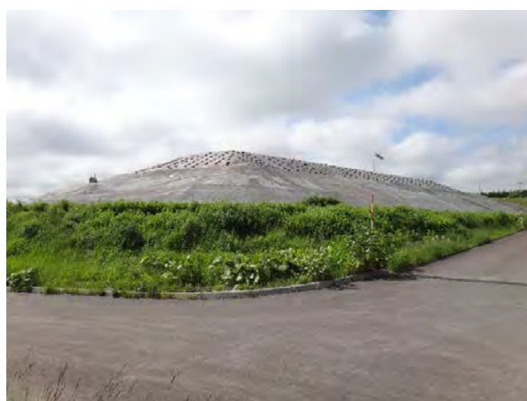
写真 43 掘削土(ズリ)の保管状況
