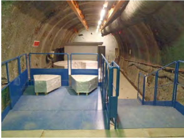
(a) 試験坑道4全景
