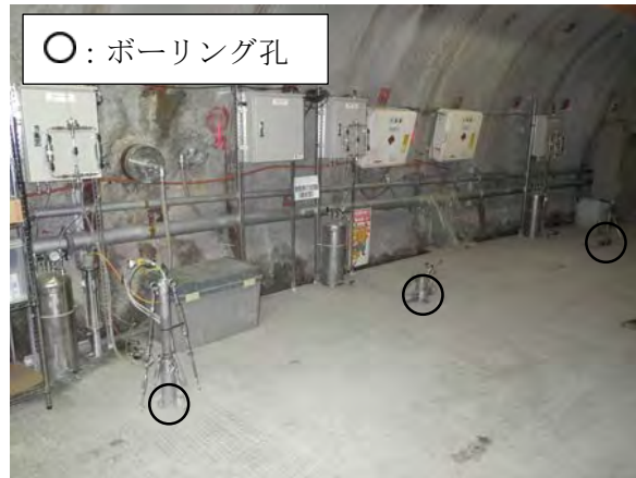
写真 35 健岩部を対象とした原位置トレーサー試験状況（装置設置）
