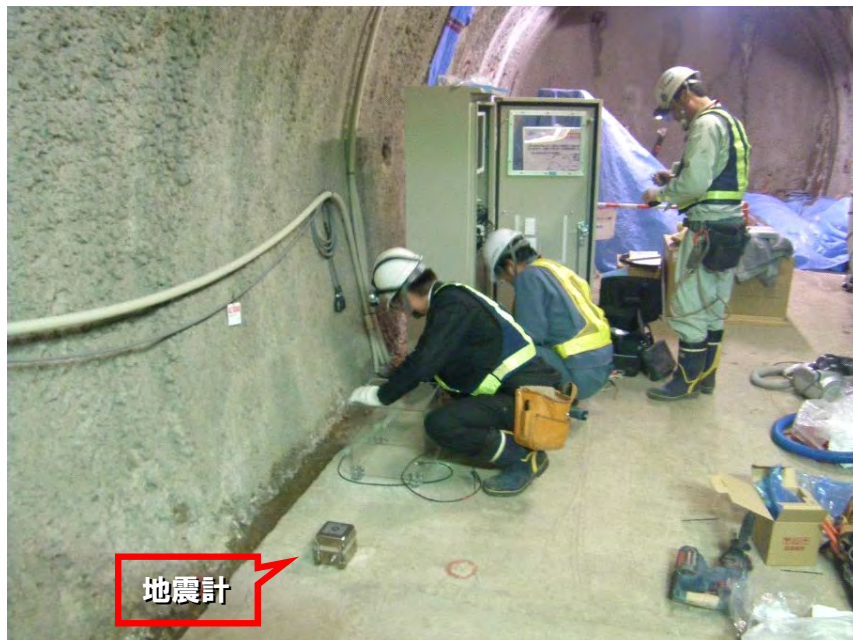
図 35 350m 調査坑道の地震計設置状況
