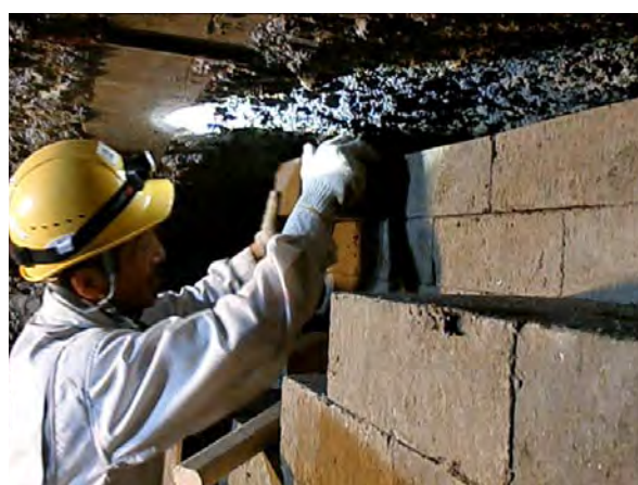
写真 10 埋め戻し材ブロックの設置状況
