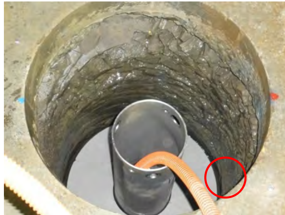
(a) 緩衝材ブロック設置
