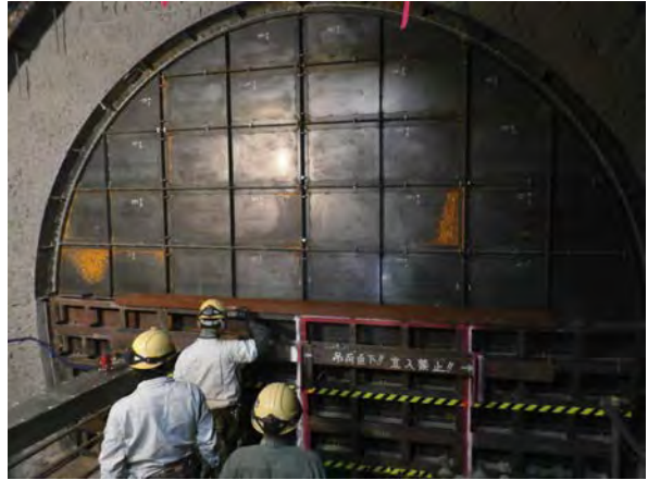
写真 12 鋼製壁の設置完了
