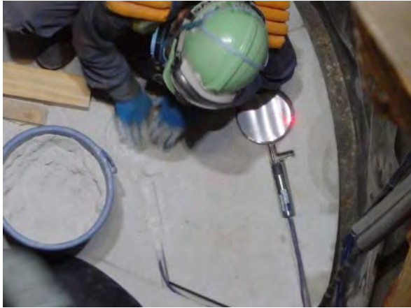
写真 4 計測センサー設置状況 計測機器設置後は、緩衝材と同じ混合材料（ベントナイト*28：ケイ砂=7:3）で隙間を埋めます。
