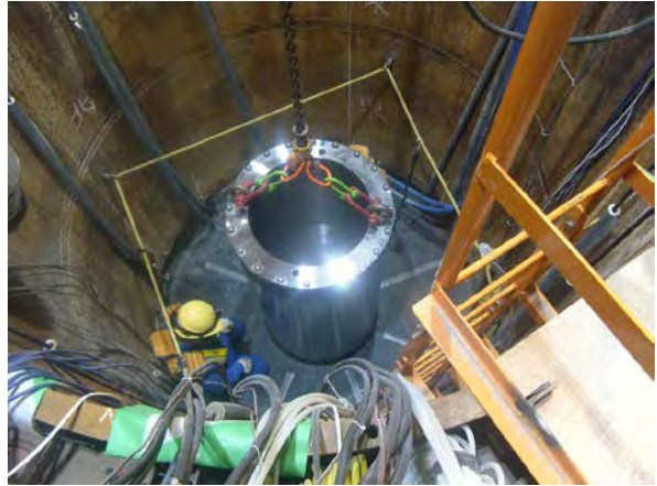
写真 5 模擬オーバーパックの設置
