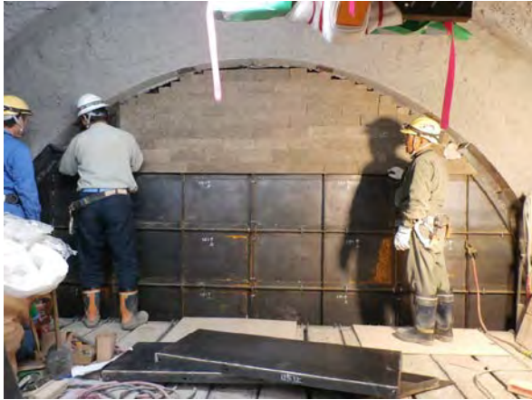
写真 11 埋め戻しブロック設置完了、鋼製壁の設置状況
