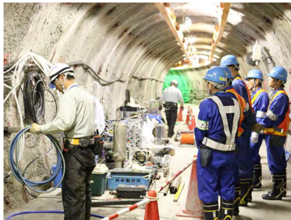
写真 53 安全パトロールの状況
