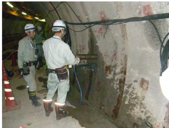
写真 36 単一割れ目を対象としたボーリング実施状況
