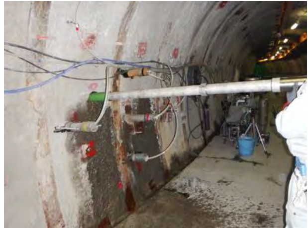
写真 38 単一割れ目を対象とした 原位置トレーサー試験 (孔内部装置設置状況)
