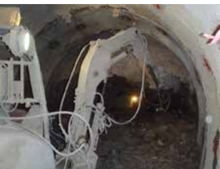
350m調査坑道周回坑道の貫通 (平成25年10月)
