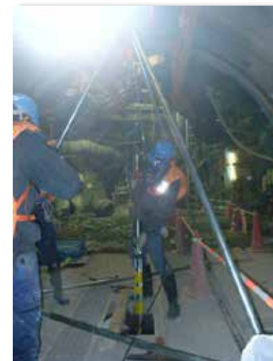
大林組-原子力機構 共同研究 マルチ光計測プローブの設置作業 (平成26年1月、於 350m調査坑道)
