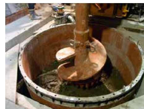
オーガー工法による中掘
