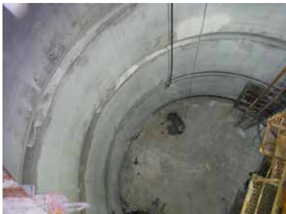
東立坑 坑底 (平成26年4月)
