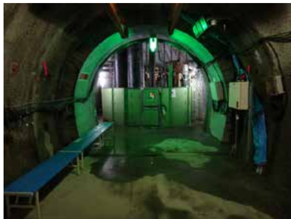
換気立坑 (平成26年6月)
