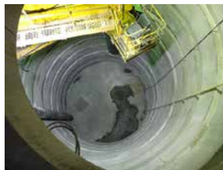
西立坑の掘削 (平成26年3月)
