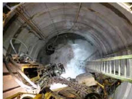
換気立坑の掘削 (平成26年2月)
