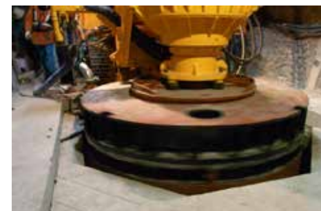
全周ケーシング工法による外周の掘削
