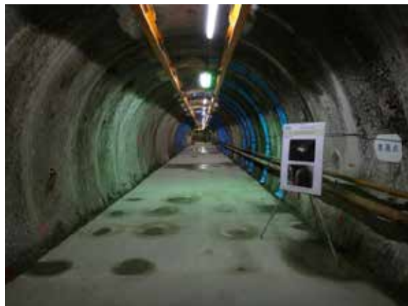
350m調査坑道 東周回坑道 (平成26年6月)
