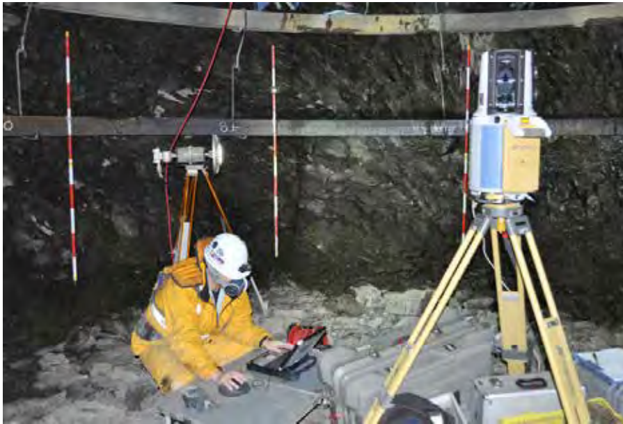
岩盤壁面の形状測定の様子 (換気立坑)
