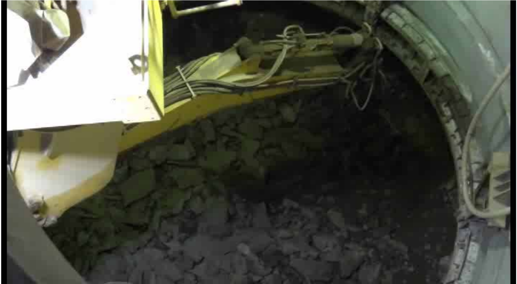
西立坑の状況 (深度350m以深の掘削)
