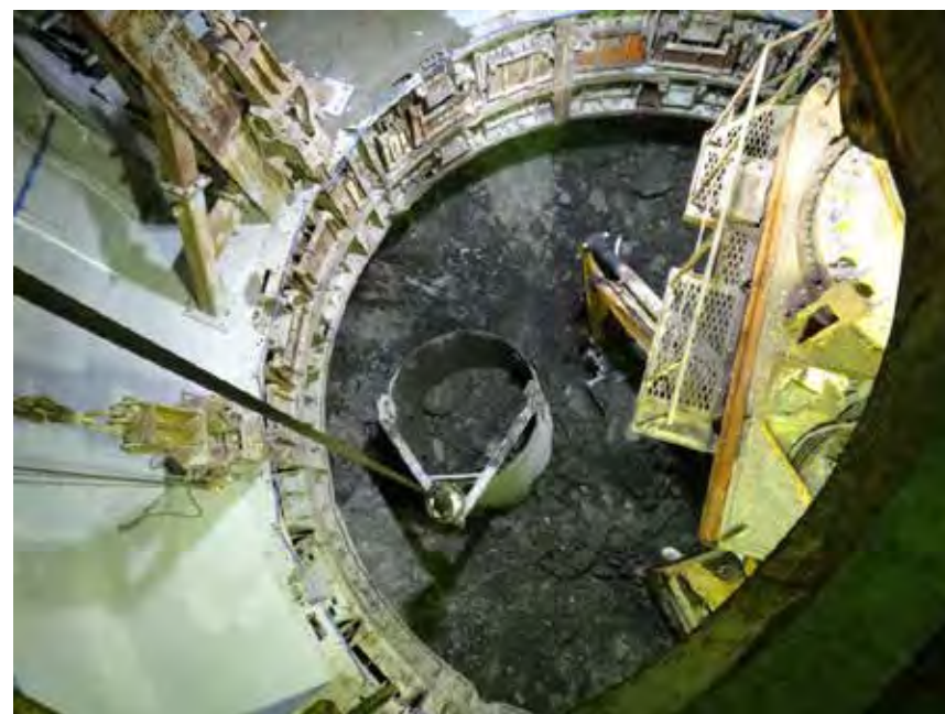
東立坑の状況 (深度350m以深の掘削)
