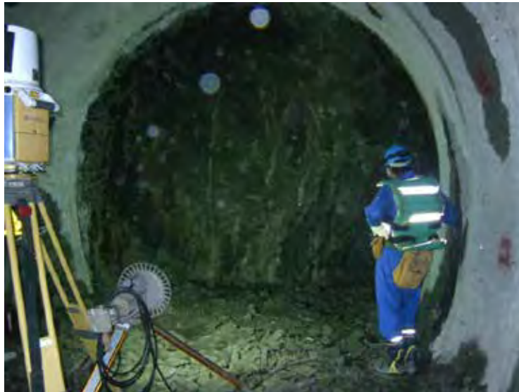
坑道壁面の地質観察の様子 (350m調査坑道)
