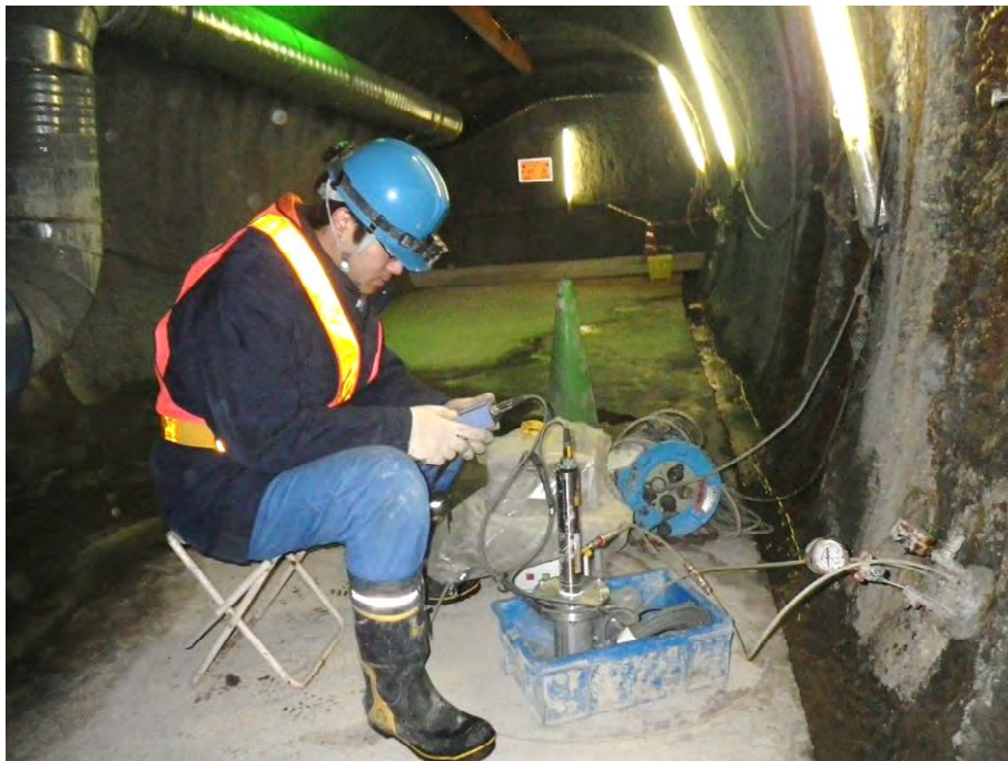
地下水の水質調査の様子（140m調査坑道）
