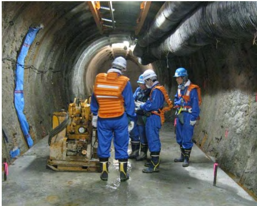
安全パトロールの様子
