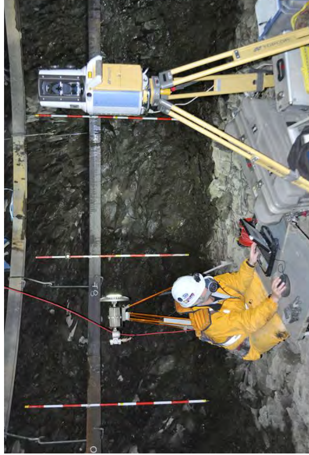
岩盤壁面の形状測定の様子 (換気立坑)
