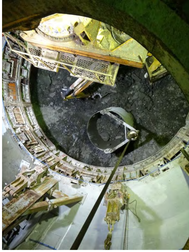
東立坑の状況 (深度350m以深の掘削)
