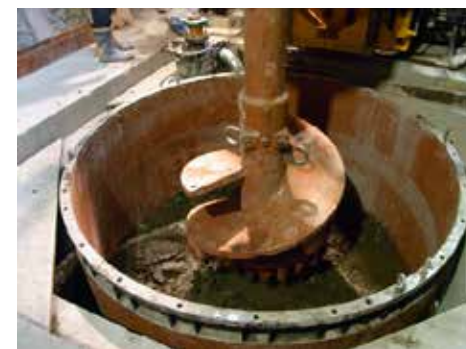
オーガー工法による中掘
