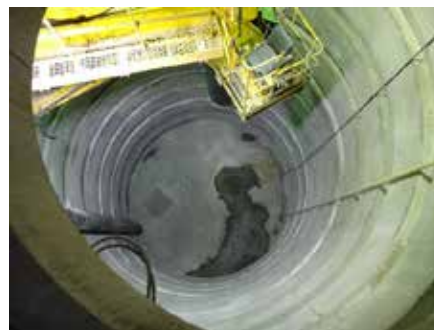
西立坑の掘削 (平成26年3月)
