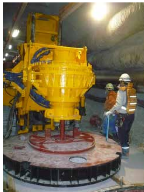
開発した大口径掘削機
