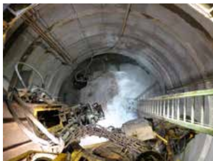
換気立坑の掘削 (平成26年2月)
