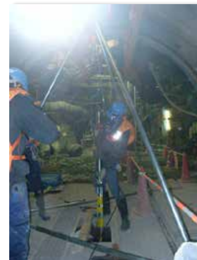
大林組-原子力機構 共同研究 マルチ光計測プローブの設置作業 (平成26年1月、於 350m調査坑道)
