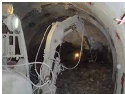
350m調査坑道周回坑道の貫通 (平成25年10月)
