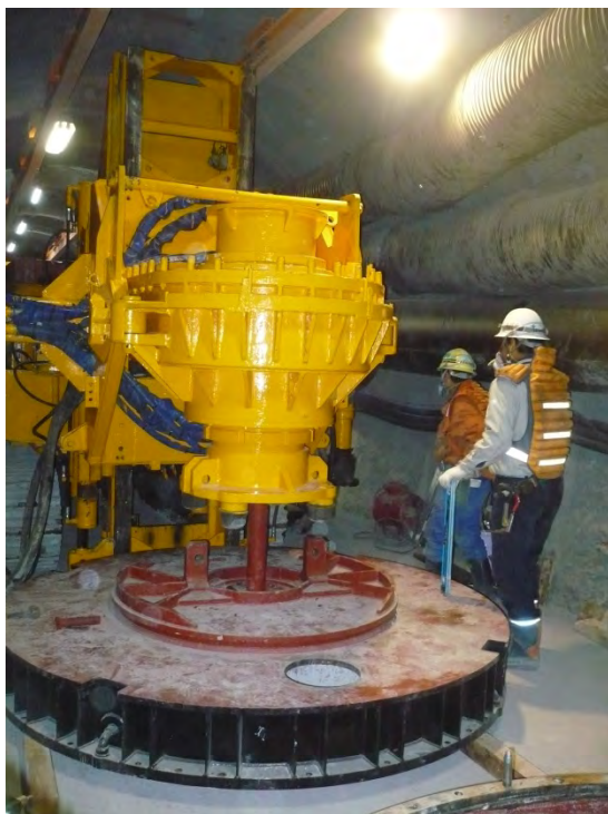
(a) 開発した大口径掘削機
