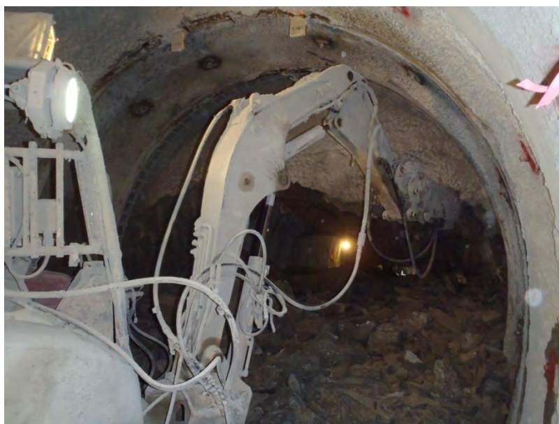
写真 18 350m調査坑道貫通状況
