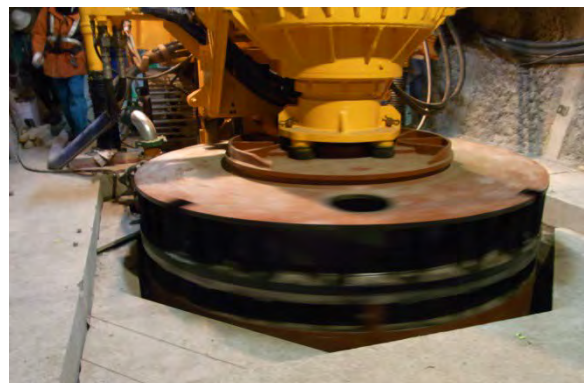
(b) 全周ケーシング工法による外周の掘削
