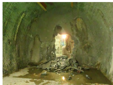
西立坑と250m調査坑道の接続 (平成24年12月)
