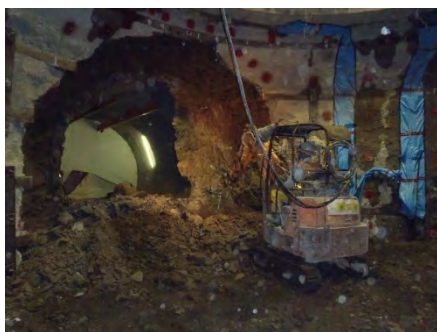
西立坑と140m調査坑道の接続 (平成24年9月)
