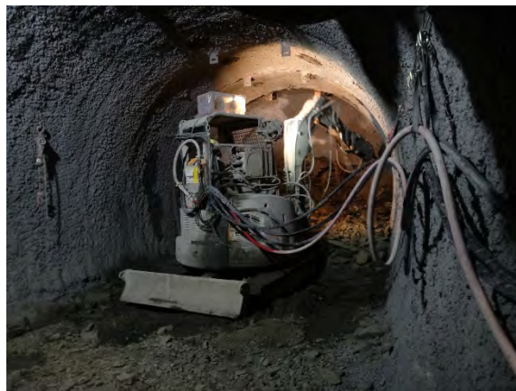
350m調査坑道掘削
