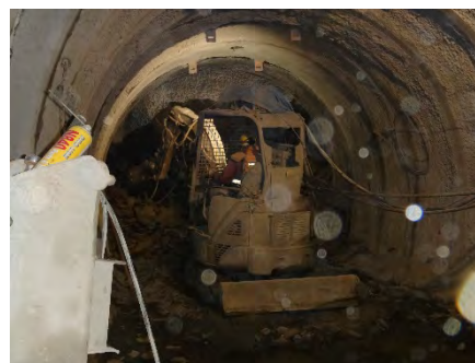
350m調査坑道の掘削 (平成25年1月)
