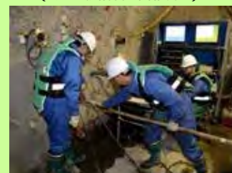
地層科学研究 (坑道掘削影響試験)
