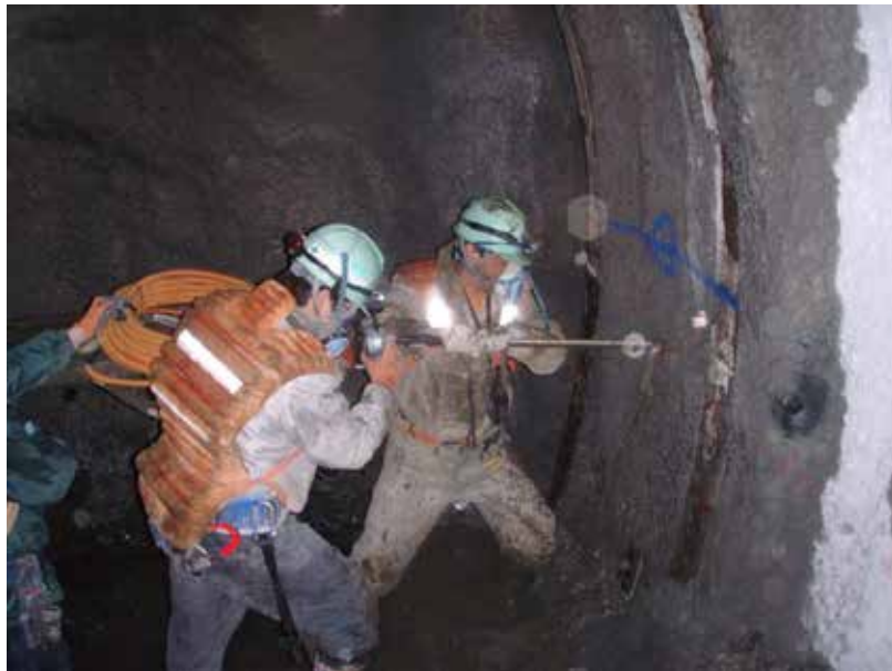
ロックボルト軸力計の設置の様子
