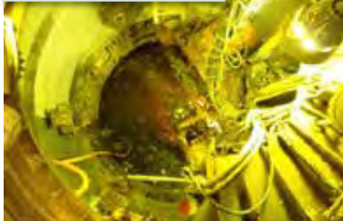
地下施設の建設
