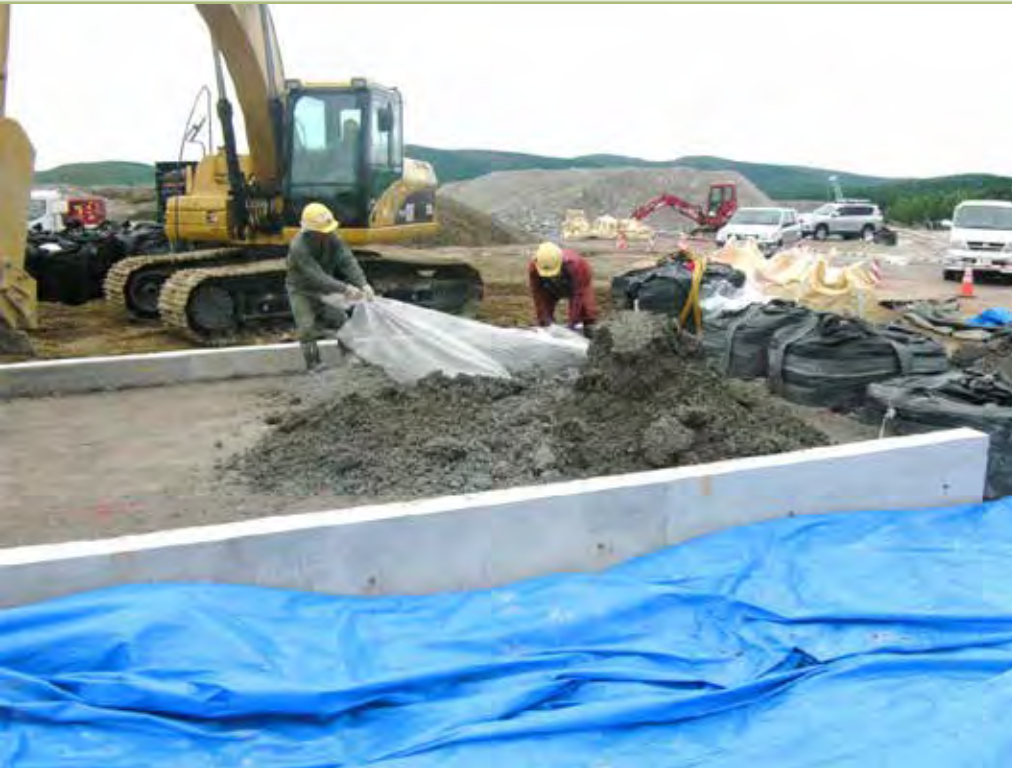
混合材料の撒き出し状況
