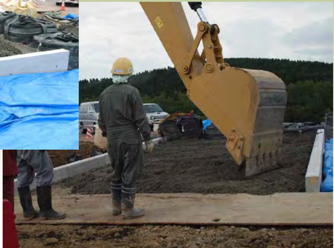
混合材料の敷き均し状況
