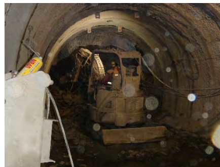
350m調査坑道の掘削 (平成25年1月)
