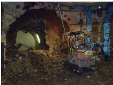
西立坑と140m調査坑道の接続 (平成24年9月)
