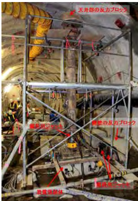
写真1 載荷試験状況
