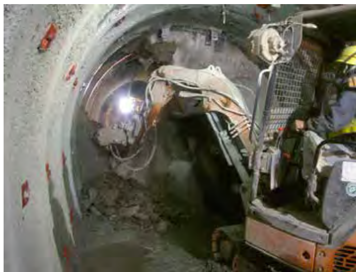
写真 7 350m調査坑道貫通状況
