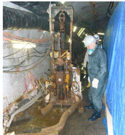
(b) グラウト注入孔の掘削状況
