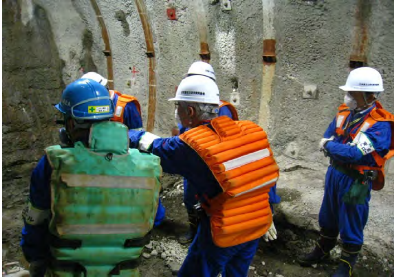
写真 9 安全パトロールの様子
