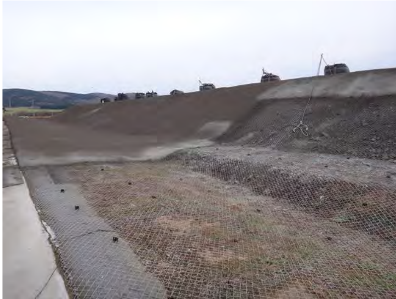
写真 8 掘削土(ズリ)置場法面モルタル吹付け状況
