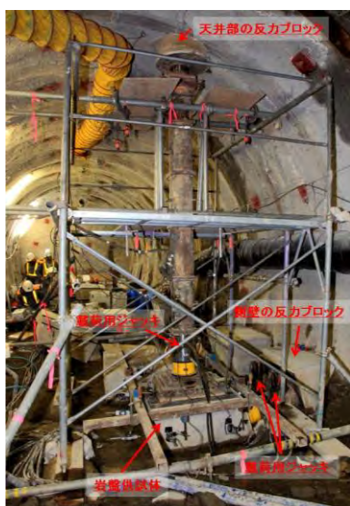
写真 1 載荷試験状況
