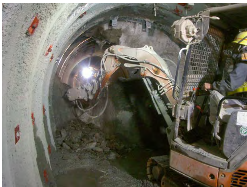
写真 7 350m調査坑道貫通状況
